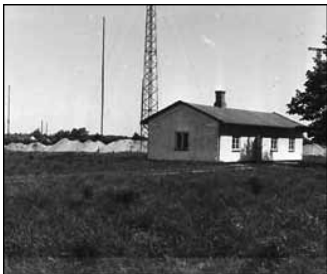
"Det gule Hus" fra 1915 – nedrevet 1967.
