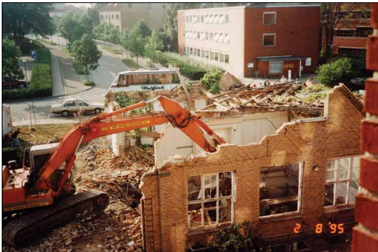
Buddinge Skole fra 1901, som fra 1908 til 1937 fungerede som kommunekontor og siden rådhus, blev revet ned i 1995. Nedrivningen begyndte 14. juli og var afsluttet 9. august. Der er nu parkeringspladser på området. Foto: Lone Dam.
