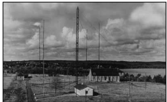
Lyngby Radio som området så ud fra 1924-1967 med de krakteristiske master - før den nye administrationsbygning blev opført.
