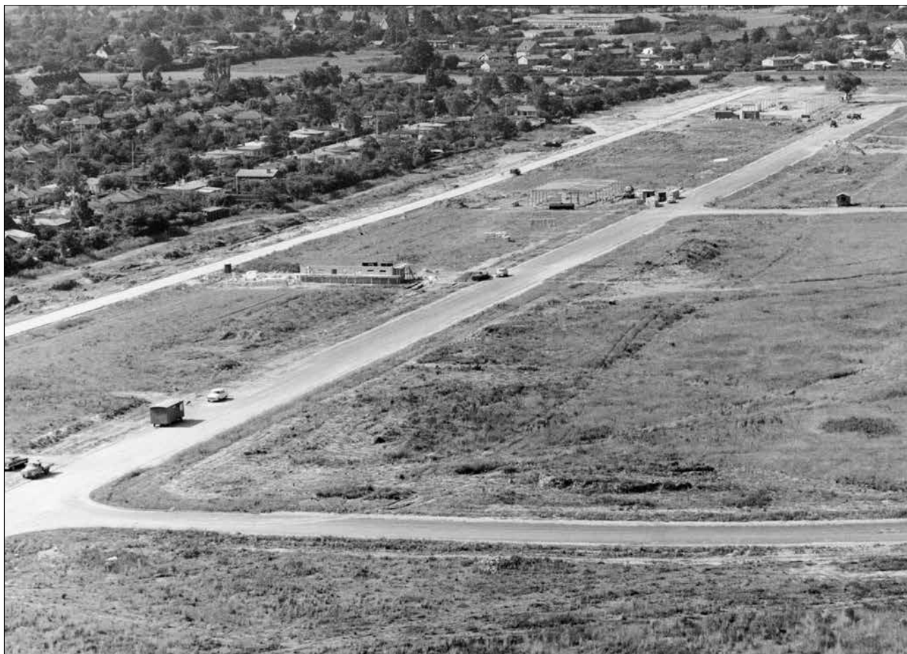
Erhvervskvarteret under anlæg i september 1964. Her er det Trasformervej nederst og Generatorvej diagonalt gennem billedet. (Foto: Eugen Amding).
