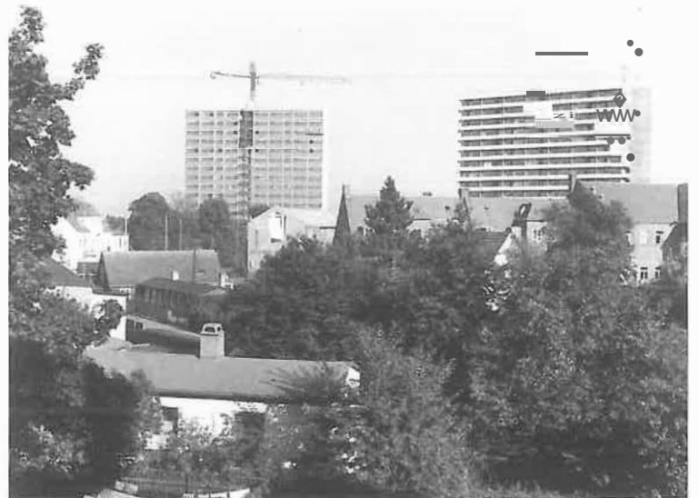
Arealet mellem Krogshøjvej og Laurentsvej, hvor den nye Vadrupvej blev ført igennem. De to nedrevne bygninger "Ligkistemagasinet" og "Hjemmets Minde" ses på billedet. Laurentsvej og Grusgraven samt en del af Grushøj og Aslaksvej er anlagt på Thorasminde's jord. Foto: Eugen Amding, 1969.
