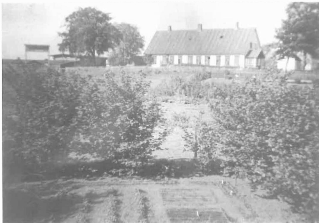
Bagsværdgård set fra nuværende Bagsværdal mod Krogshøjvej.
