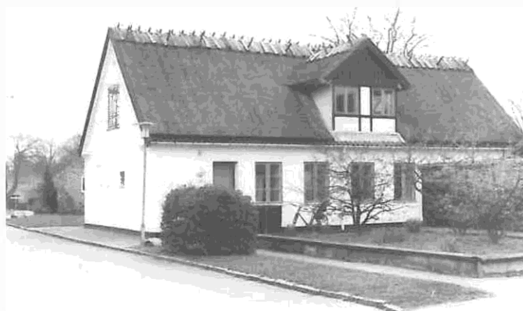
Den velbevarede hovedbygning fra Søndergård. Søndergård Park bebyggelsen blev projekteret i 1947 og '48. I 1949 var der rejsegilde og de første beboere flyttede ind i december samme år. I 1957 og '58 blev selve Søndergårds bygninger ombygget og indrettet til en børneinstitution. I dag er her fælleslokaler. Foto: Lone Dam, 1999.
