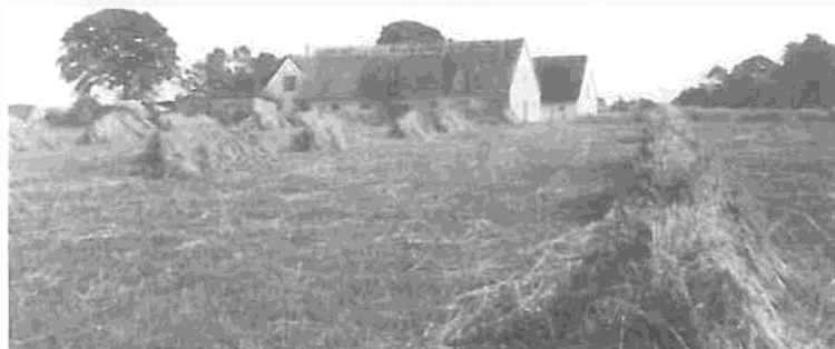
Søndergård som den lå på marken. Hovedbygningens gavl kan lige ses bag den forreste afladerne.
