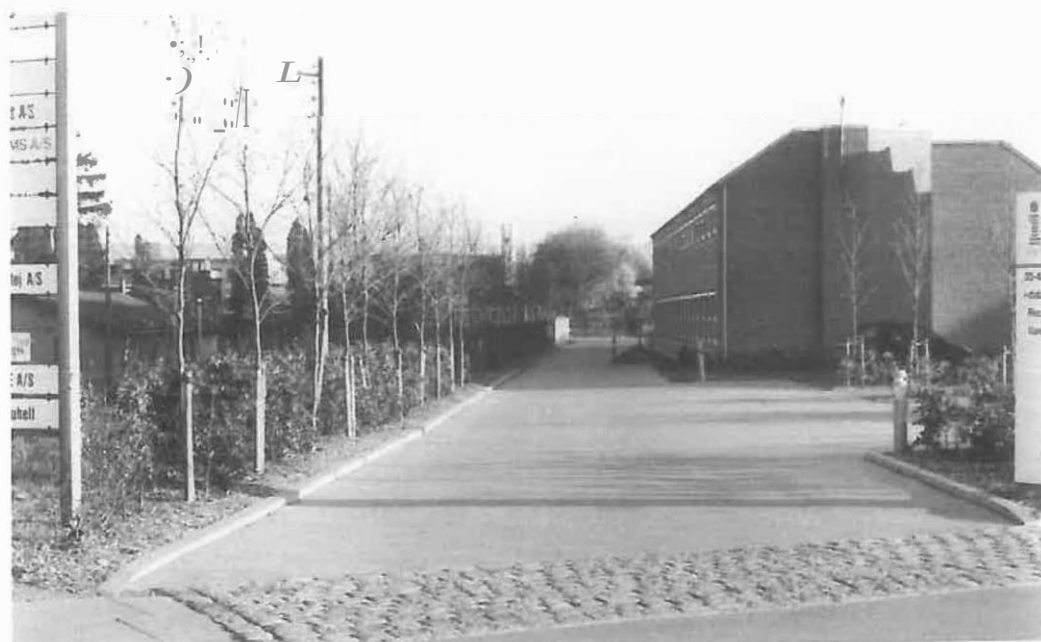
Grusgraven 1999 taget samme sted som billedet fra 1910. Foto: Lone Dam.
