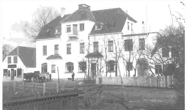
Bagsværd kro fik en ekstra etage tilføjet i 1905 og fik ved den lejlighed det udseende, der med ganske få ændringer skulle vedblive at være indtil den blev revet ned i 1975. Indvendig bevarede man så vidt muligt det gamle udseende med høje paneler overalt, men kun i baren var det de originale, gamle, almuegrønne paneler med udskæringer, der var bevaret. Billedet stammer fra ca. 1905, umiddelbart efter den store ombygning.
