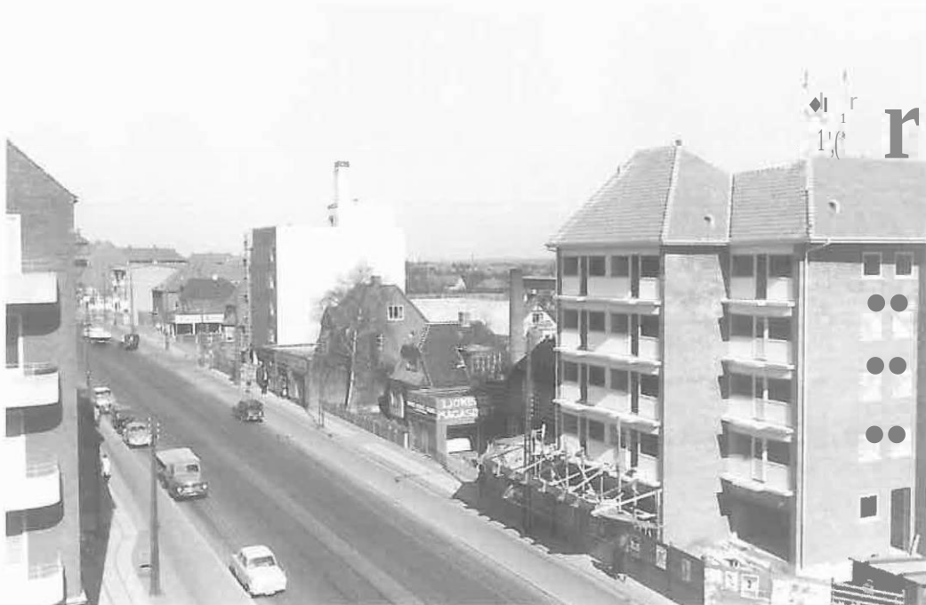
Tesch's Gård lå mellem nuværende Niels Finsens Alle og Dickens Alle. Udstykningen blev allerede påbegyndt i slutningen af 1800-tallet. Den største del af udstykningen foregik fra 1905 til 1919. Billedet viser udsigten fra Niels Finsens Alle med byggeriet af boligblokken ud til Søborg Hovedgade mod Dickens Alle, der ligger for enden af boligrækken. Foto: ca. 1959.
