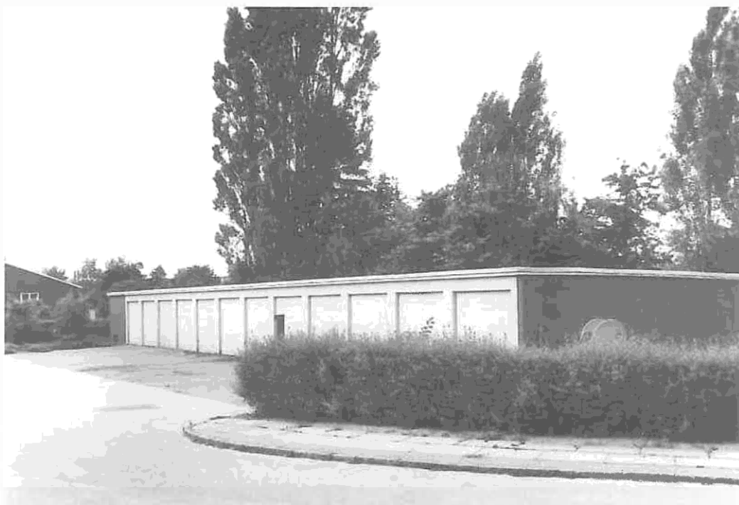
Bag garagen på Kontorvej ligger anlægget med de store træer, der som det eneste, indikerer, at Kildegård lå her tidligere. Foto: Lone Dam, 1999.
