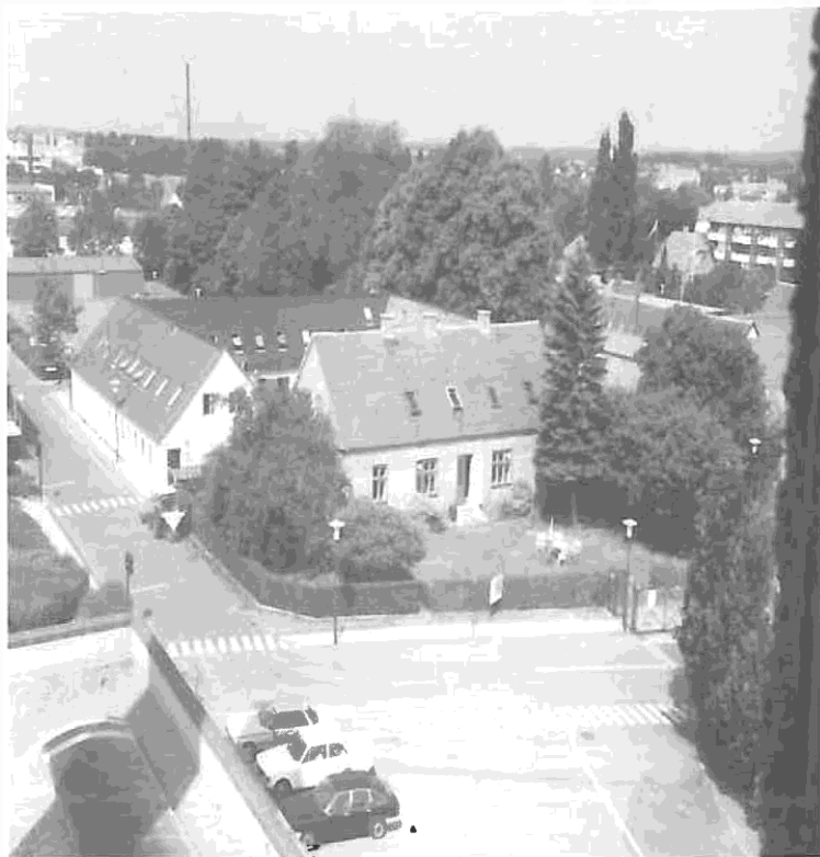
Så smukt tog gården sig ud efter restaureringen som blev foretaget i 1982. Billedet er taget i 1992, umiddelbart inden nedrivningen.
