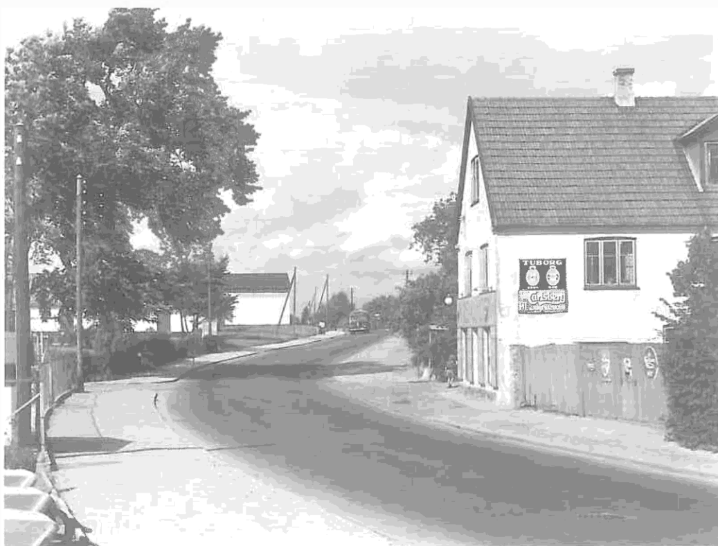
Saxgård lå på Gladsaxe Møllevej 93-109. Til venstre i billedet ses en af Saxgårds lader, der lå umiddelbart efter indgangen til Haveforeningen Carl Nielsens Minde. I 1943 eksproprierede Gladsaxe kommune laderne ud til vejen, da Gladsaxe Møllevej skulle udvides. Gården lå der stadig, da man byggede Egegård skole på hjørnet af Klausdalsbrovej i 1957-58. Gården blev revet ned i 1960'erne til fordel for et etagebyggeri. Til højre i billedet ligger i dag Branddamsbyggeriet. Foto: Eugen Amding, 1953.
