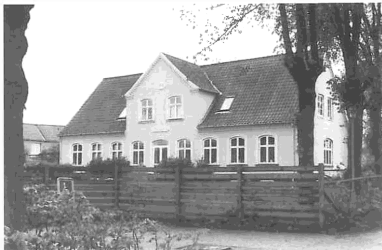
Pilegård på Gladsaxe Møllevej 63-65 står smukt bag lokal-kontoret. Huset bruges nu til ungdomsformål. Foto: Lone Dam, 1999.
