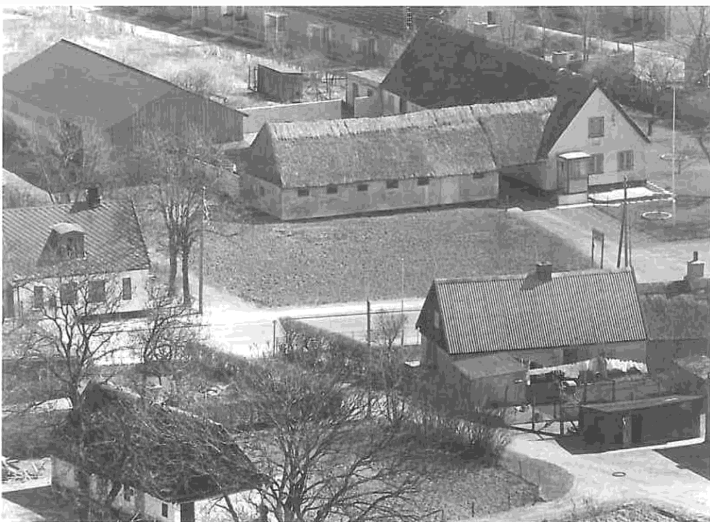
Toftegård i Mørkhøj set fra gastårnet i april 1955. Toftegårds jorder blev systematisk udstykket i større stil i begyndelsen af 1930'erne og villa- og rækkehuskvarterer skød op. Selve Toftegård blev revet ned i 1980 og gav plads til rækkehusbyggeriet Toftegården. Foto: Eugen Amding.
