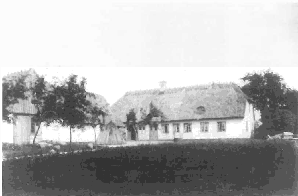
Annexgård på adressen Mørkhøjvej 268-270 omkring 1940. Gården brændte delvist i 1953, men i ganske mange år derefter lå den bygning tilbage, der havde huset kroen.
