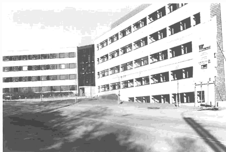
Ferrosan, Sydmarken 1-5, var en af de første store virksomheder, der flyttede ud på Kildegårds jord. Her ses den gamle bygning til venstre og den nye tilbygning fra 1998 til højre.
