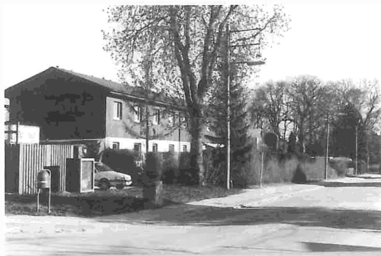
Toftegård i Mørkhøj 1999. Toftegård lå på hjørnet af Bygaden og Hjortestien. De nye rækkehuse har adresse på Hjortestien 2A-D, men ligger iøvrigt nøjagtig på gårdens plads. Foto: Lone Dam.
