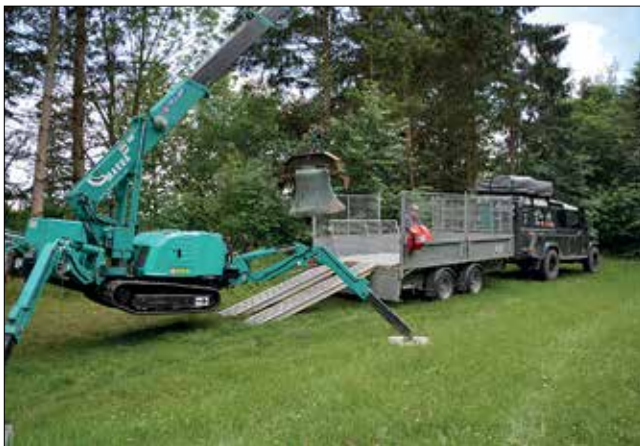
Kim Keincke i gang med at læsse klokken på Næsbycenteret. (Foto: FB).
