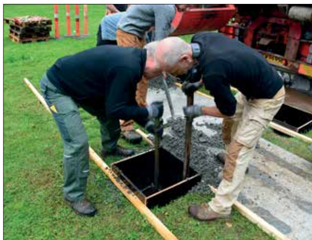
Fundamentet støbes på Gladsaxe Kirkegård. (Foto: FB).
