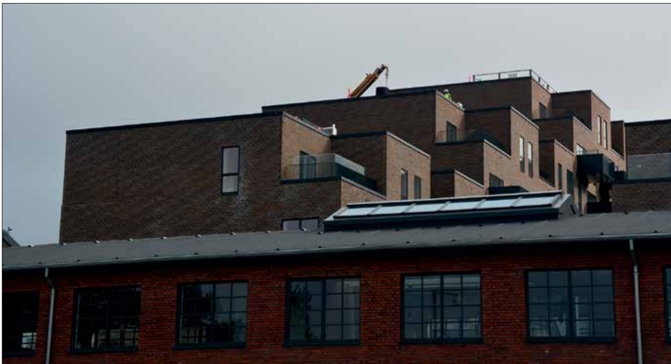
Den renoverede bygning mod Gladsaxevej med klippelandskabet af lejligheder i baggrunden, som i marts 2020 er ved at blive færdiggjort. (Foto: Flemming Bruun).
