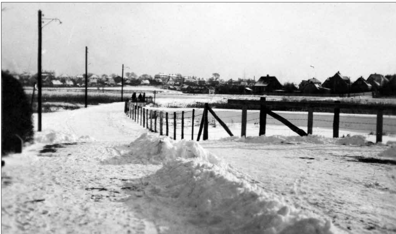
Frem til midten af 1930'erne foregik færdsel mellem Maglegårds Allé og Horsebakken på Københavnsiden via en træbro for gående og cyklister. I 1938 kom der betonbro. Det krævede ændringer af kommunegrænsen, og København fik vedligeholdelsespligten. (Foto: Gladsaxe-billeder, ukendt år).
