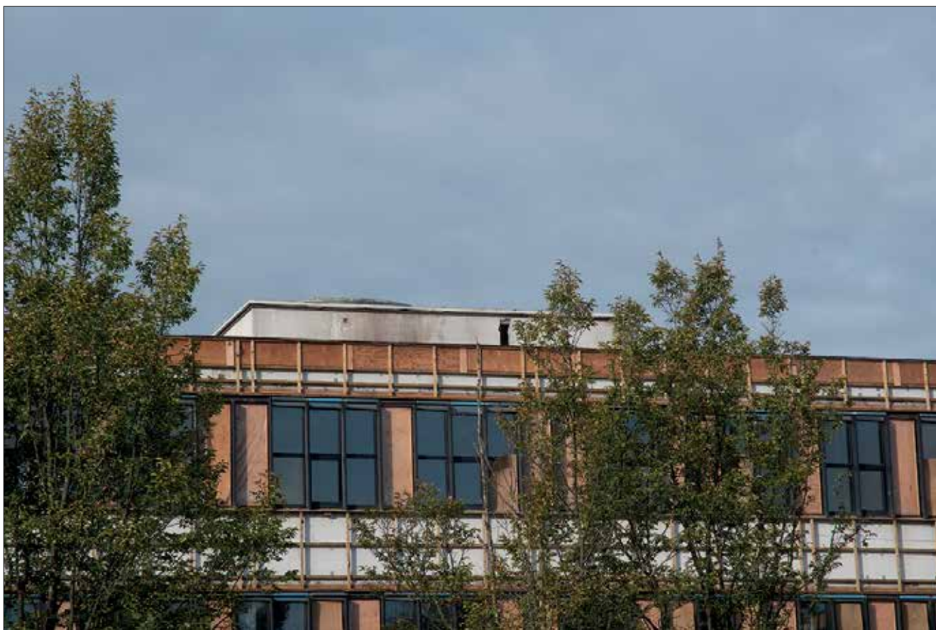
Gladsaxe Skole midt oktober 2020. Nedrivningen er i fuld gang, og kuplen er nænsomt fjernet med en kran. (Foto: Jens Mortensen).
