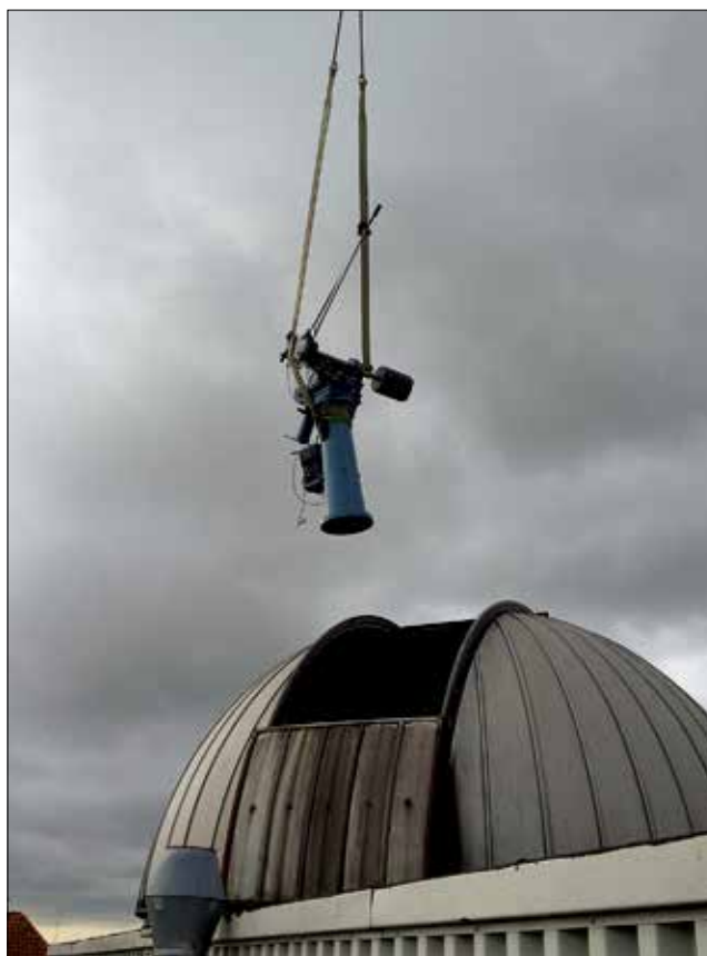
De tungere dele af kikkerten, monteringen, blev bragt ud af kuplen med en kran.
